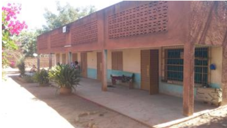
Le Centre avant les travaux.
